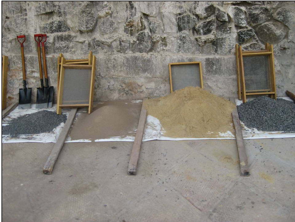
Mantener pilas de material ordenadas y separadas ayudará a evitar que el material se mezcle.
